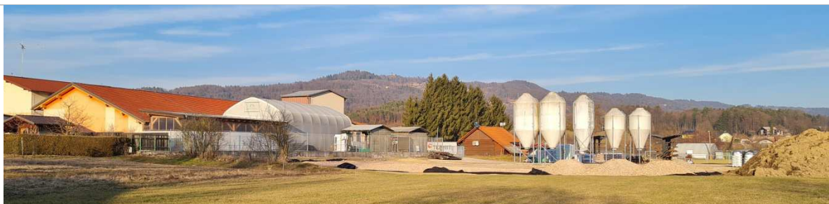
ogled na obravnavano lokacijo z zahoda (Foto: P. Pogačar, februar 2022)
